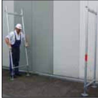
Установка вертикальных рам
