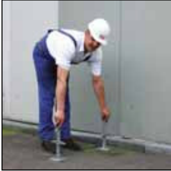
Установка оснований с резьбой
