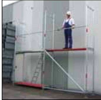
Монтаж ограждающих поручней
