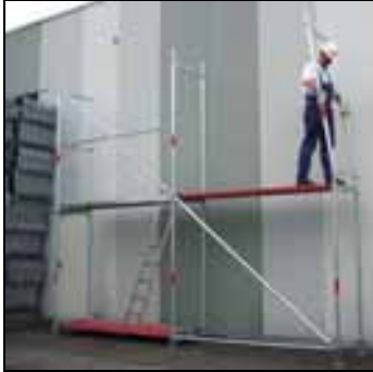
Установка вертикальных рам последующего яруса
