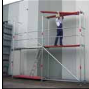
Установка площадок последующего яруса
