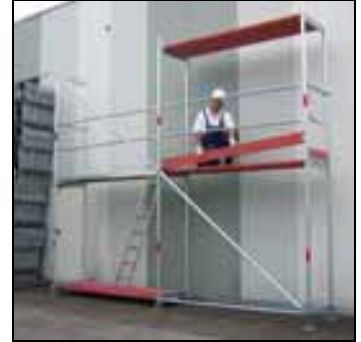
Установка бортовых досок
